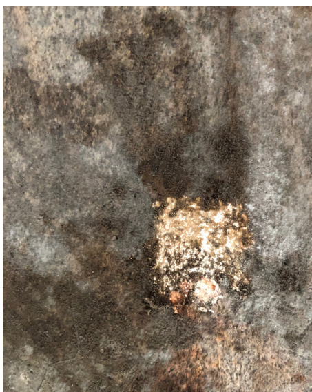
Fot. 9 Transept, w odkrywcę widoczne zniszczenia warstwy malarskiej pod grubą warstwą grzybni
