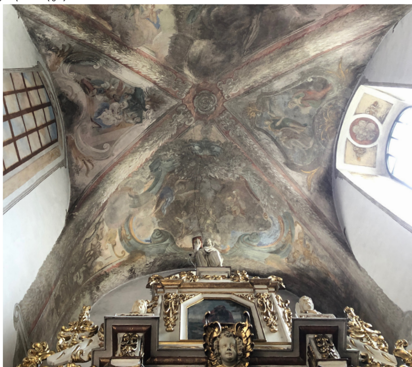
Fot. 9 Transept, w odkrywcę widoczne zniszczenia warstwy malarskiej pod grubą warstwą grzybni
