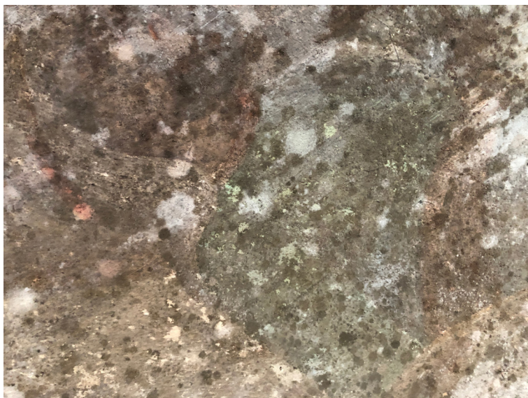
Fot. 10 Transept, w zbliżeniu widoczne brunatne i siwe skupiska mikroorganizmów.
