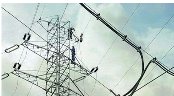
Prace modernizacyjne na linii elektroenergetycznej
